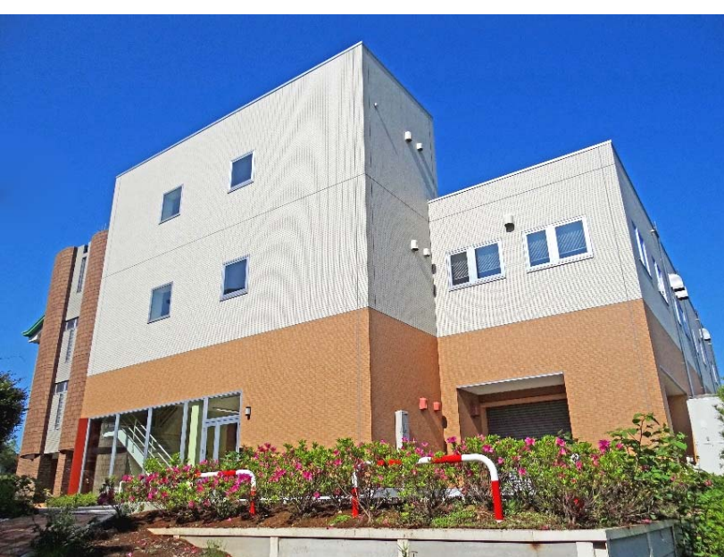
《 共通棟別館（東面） 》
