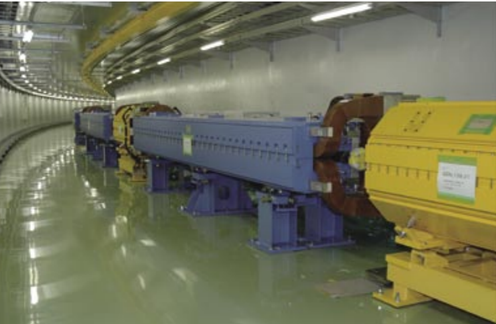
図1 PSの100倍以上のビーム強度を目指すJ-PARCの50GeVシンクロトロン。2008年5月に加速器のビーム試験開始、2009年4月にニュートリノラインのコミッション開始予定である。
