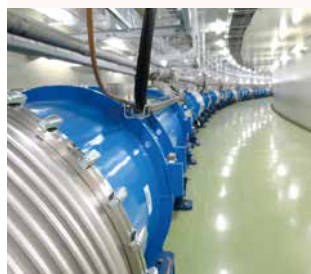
J-PARCニュートリノ実験施設の超伝導電磁石
