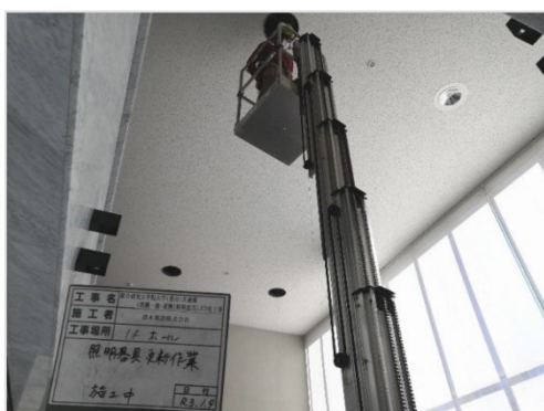
LED 照明器具取付(共通棟正面玄関ホール天井)
