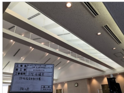
LED 照明器具取付(共通棟 3 階会議室天井部)
