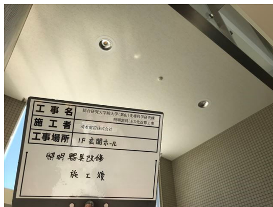
先導科学研究科棟 1階玄関ホール天井 (施工後)
