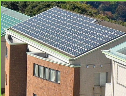
図書館 設備容量 20kW
