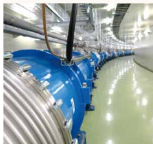
J-PARC ニュートリノ実験施設の超伝導電磁石
