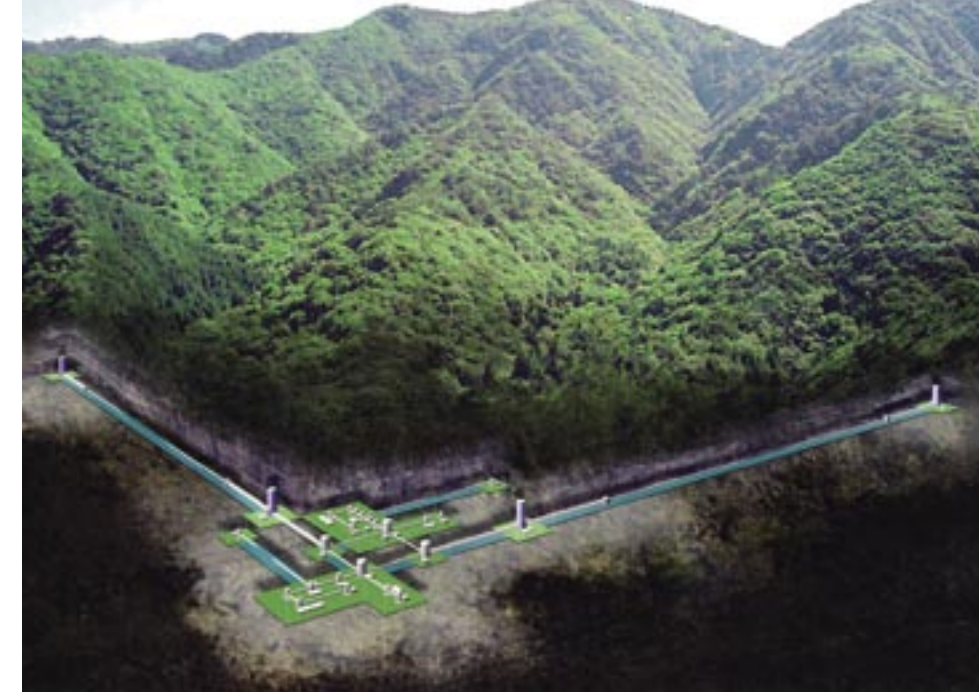
図2 LCGTの基本概念。地面振動の静かな神岡鉱山内に基線長3kmのトンネルを掘削し、そこに冷却サファイアミラーを組み込んだレーザー干渉計を設置する。
