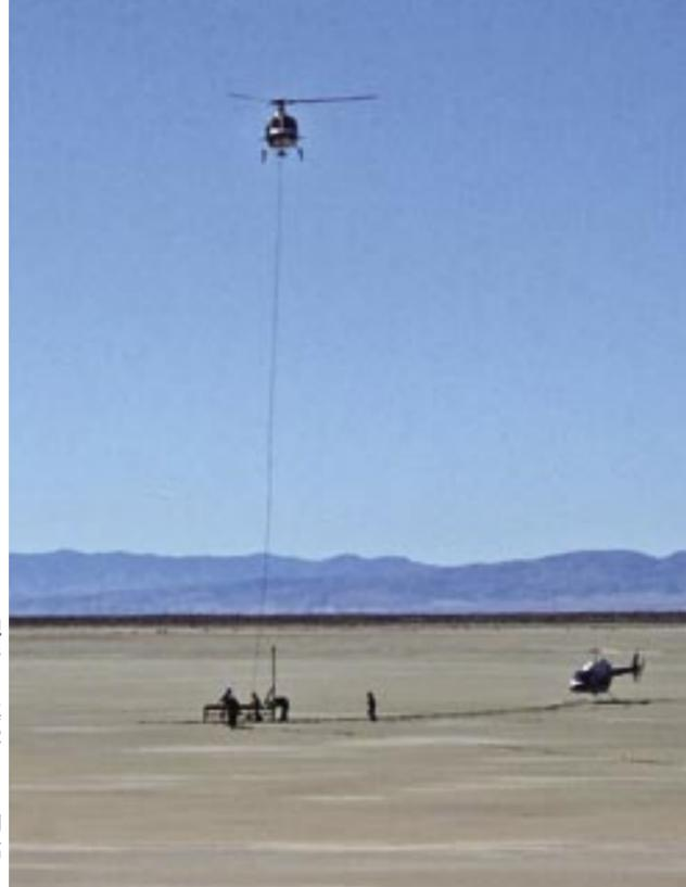
図2 超高エネルギー宇宙線の観測のため、東京大学宇宙線研究所を中心とする研究グループは、アメリカ・ユタ州の砂漠地帯に大規模な観測網を建設中である。この写真はその建設作業の一コマ。ヘリコプターでつり下げられているのは宇宙線の観測装置で、同型の観測装置を砂漠に数百台展開して超高エネルギー宇宙線を検出する。
