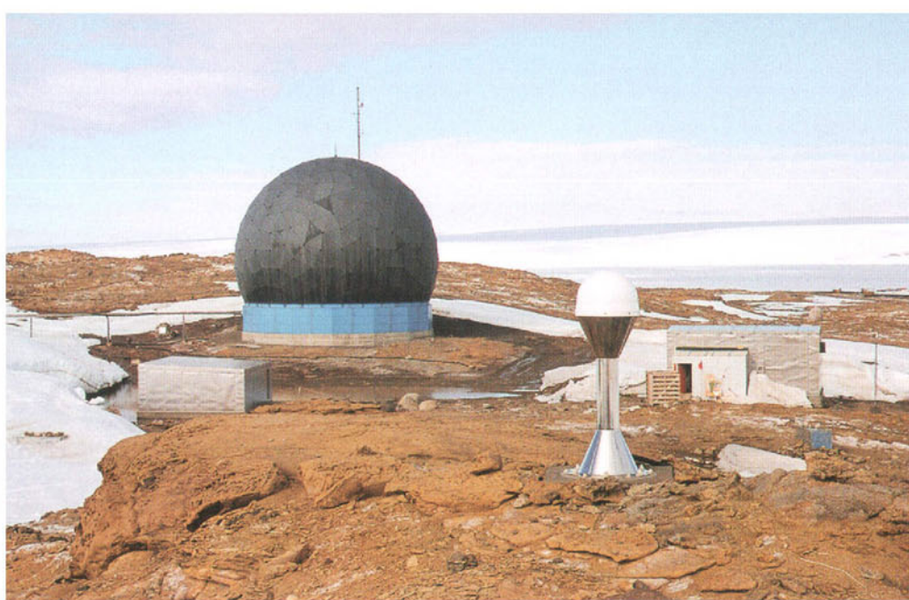
昭和基地内の多目的アンテナ（衛星受信とVLBI用）とGPSアンテナ（手前）
