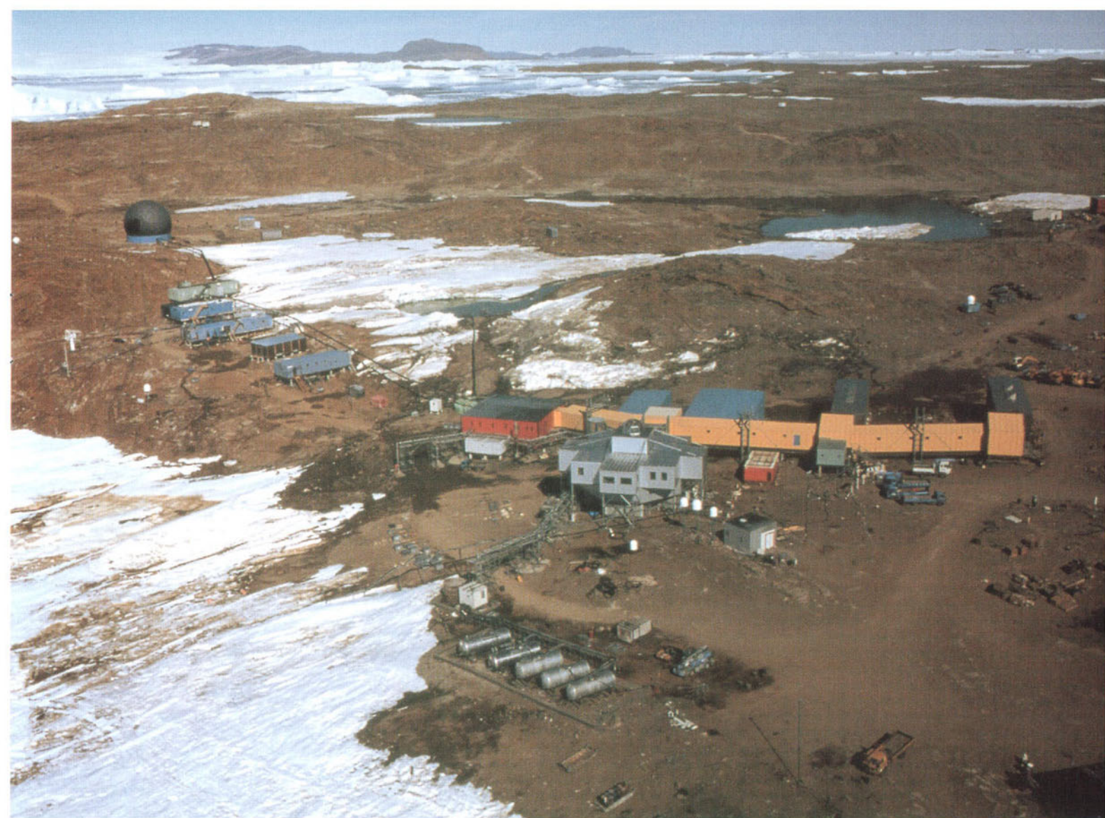
日本の南極観測の拠点である昭和基地の主要部。1957年1月、東南極の大陸の縁から4km離れた東オングル島上に開設された（南緯69度、東経39度35分）。管理棟（中央の3階立ての建物）、発電棟、居住棟、観測研究棟、環境保全関連施設、衛星受信棟、倉庫など49棟の建物のほか、アンテナや燃料タンクが点在する。日本の南極観測基地はほかに、みずほ基地、ドームふじ観測拠点、あすか観測拠点がある。ドームふじ観測拠点は氷床深層掘削を目的とした大陸内部の基地。みずほ基地とあすか観測拠点は、かつての越冬観測基地で、現在は内陸へのベースとして使われている。
