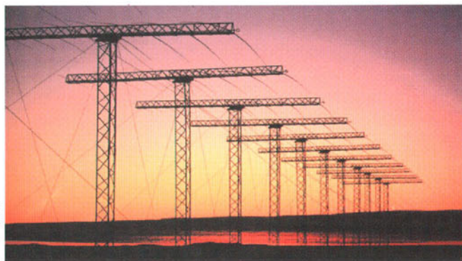
昭和基地周辺部に設置された SuperDARNレーダー。南極 域6基、北極域9基のレーダー が電離圏を国際協同観測する。
